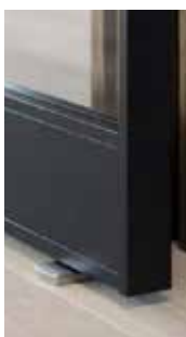
Pivotband bei 90° Öffnung
