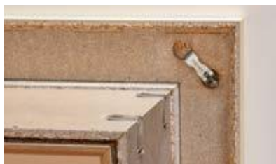
Eckverbindung für Vollgehrung
